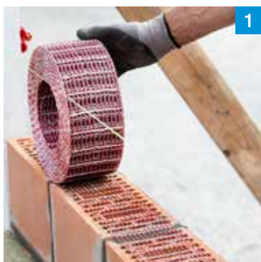
1 Rozłóż Murfor® Compact I na elementach murowych.
