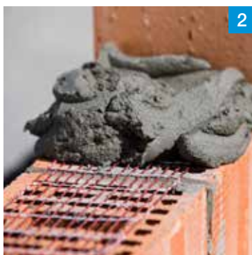
2 Nałóż warstwę zaprawy.
