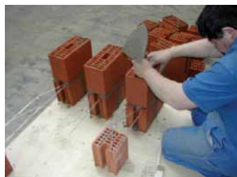
Rys. 4: Ułożenie kolejnej warstwy pustaków
