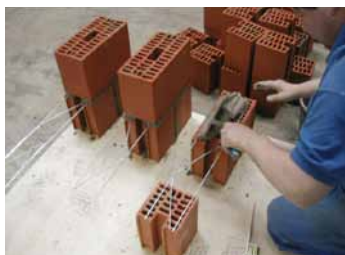
Rys. 3: Rozprowadzenie warstwy zaprawy z wierzchu
