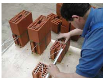
Rys. 2: Umieszczenie zbrojenia spoin wspornych bezpośrednio na pustakach
