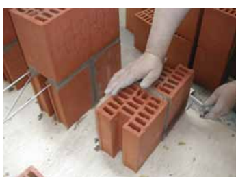
Rys. 1: Ułożenie dolnej warstwy pustaków
